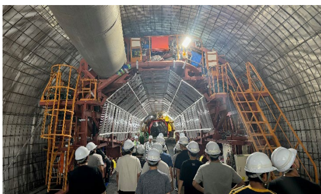
山鳥坂ダム 仮排水トンネル
