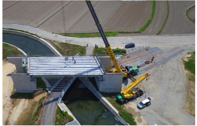
架設の様子をドローンで上空から見学
