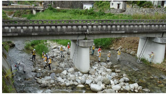
現場実習 (橋梁)
