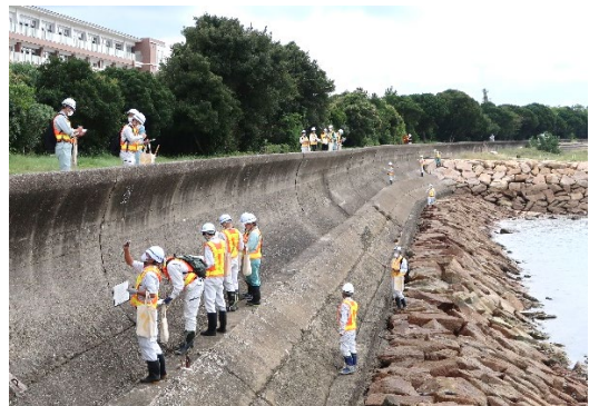
現場実習 (海岸施設)
