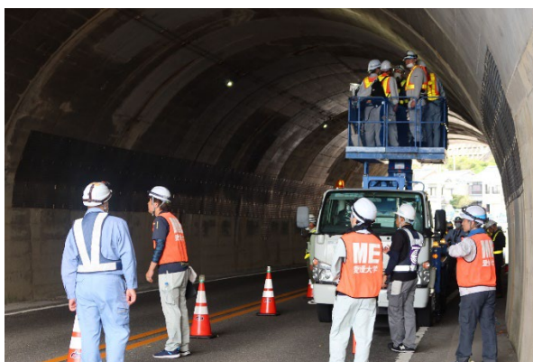
トンネル（砥鹿山隧道）
