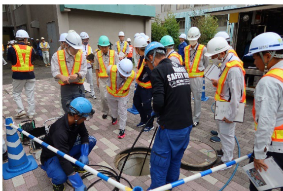
下水道（愛媛大学城北構内）
