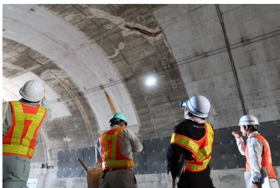
トンネル（砥鹿山隧道）
