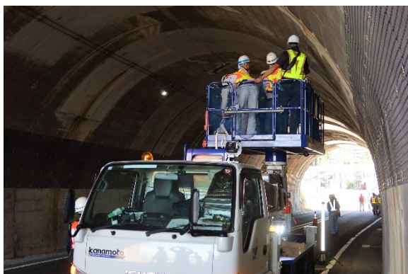
トンネル（砥鹿山隧道）
