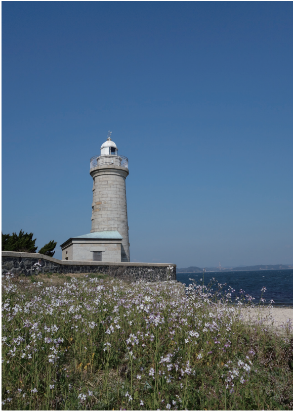
写真1 コーニス状に拡張して配置したベランダが愛らしい男木島灯台
