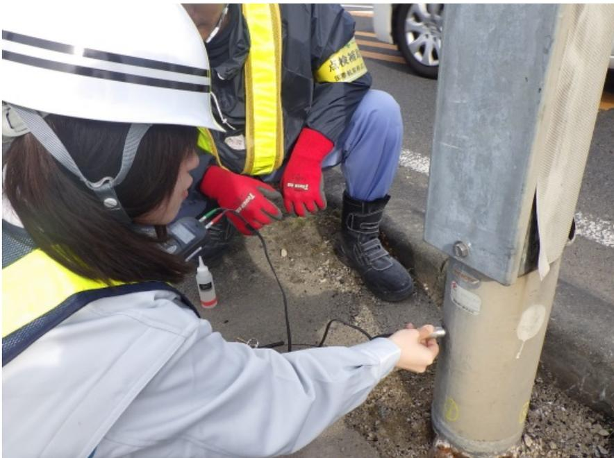
レーダで板厚を計測し、腐食がないかの検査をしています。
