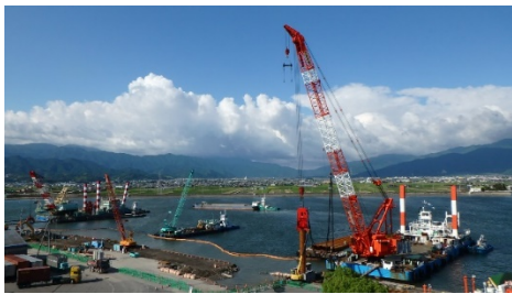
東予港岸壁工事最盛期
