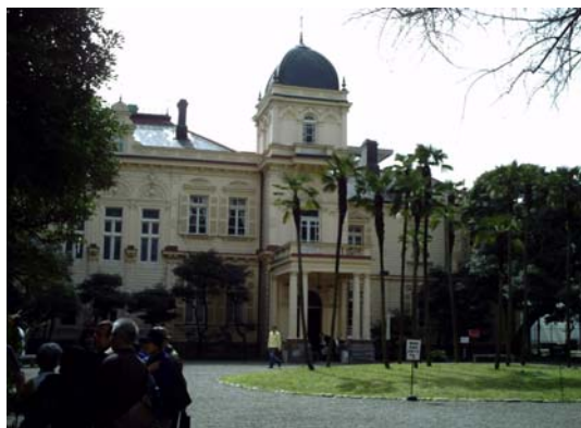
写真1 洋館正面(北面)
