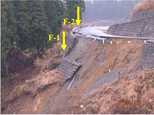
図-5 調査地点 F-1, F-2 における被害状況と簡易貫入試験の実施位置
