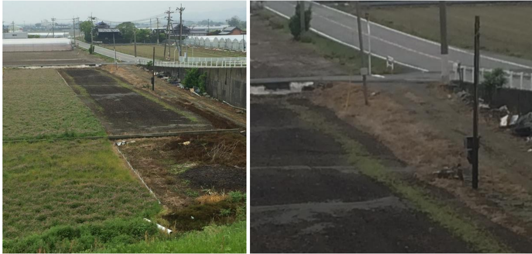
写真 2.7 畑で生じた噴砂と電柱の沈下
