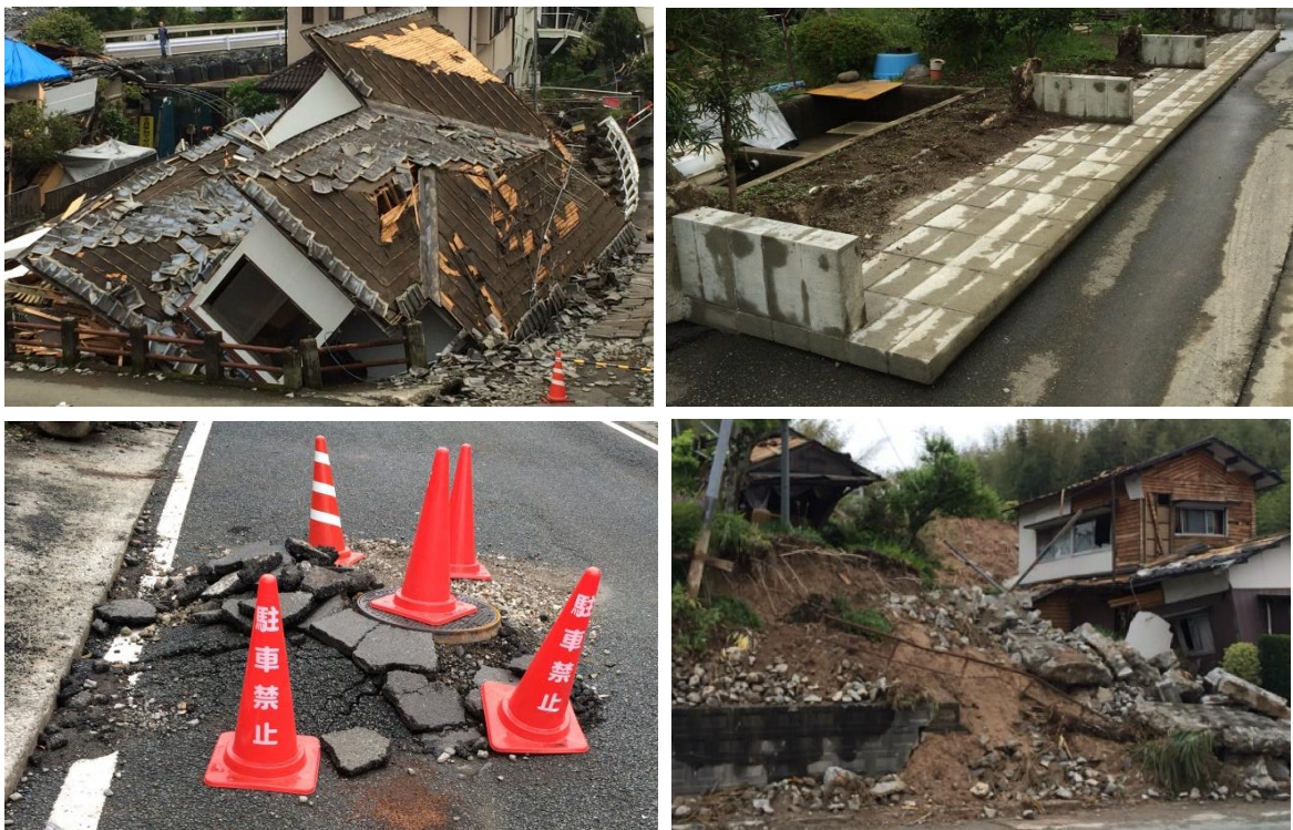
写真 2.16 家屋の倒壊（左上） 塀の倒壊（右上） マンホールの浮き上がり（左下） 斜面崩壊（右下）
