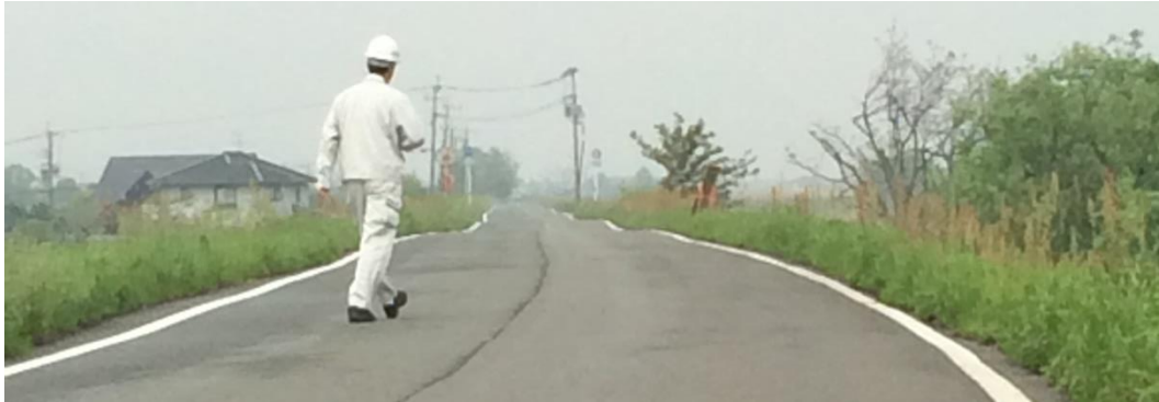
写真 2.3 天端上の不同沈下
