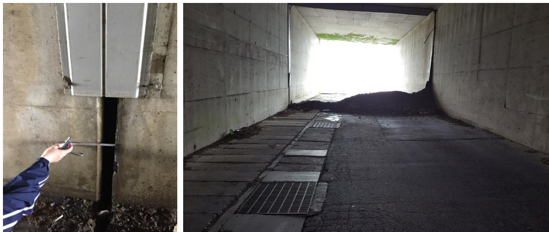
写真 2.15 ボックスカルバートの分離（左）高速道路の盛土落下（右）
