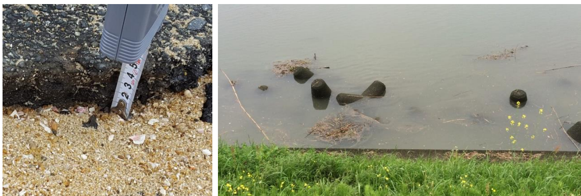
写真 2.6 クラックによる段差 (左) テトラポットの沈下 (右)
