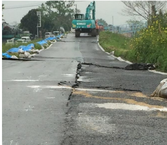
写真 2.11 天端の沈下
