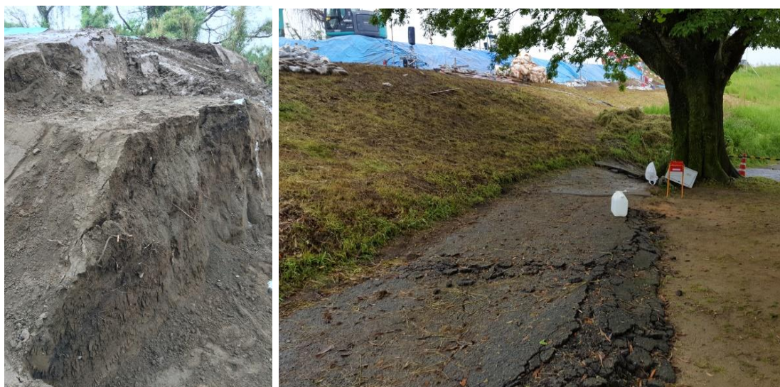
写真 2.13 砂堤防（左）法尻部の側方流動（右）
