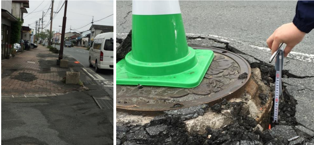
写真 2.9 歩道の液状化被害（左）マンホールの浮き上がり（右）
