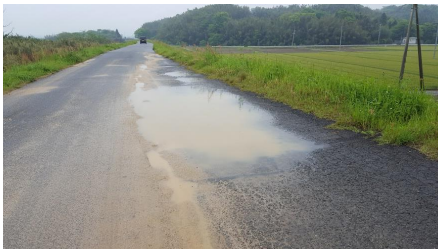
写真 2.12 天端の沈下および縦断クラック
