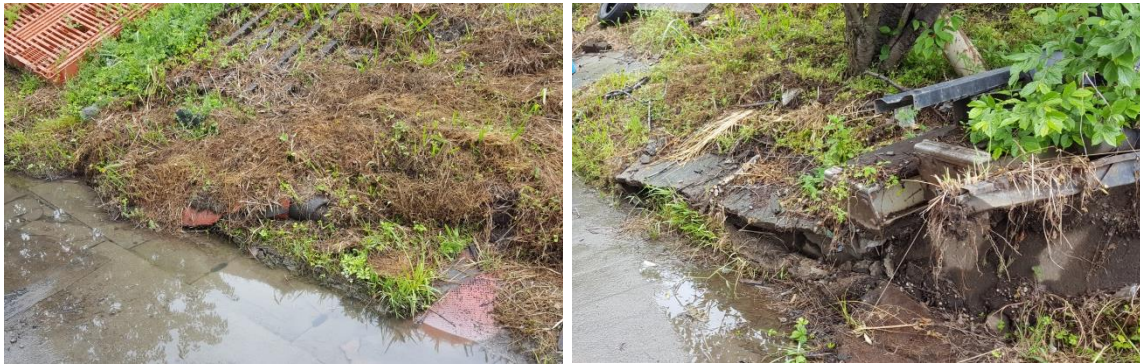
写真 2.14 法尻部の側方流動
