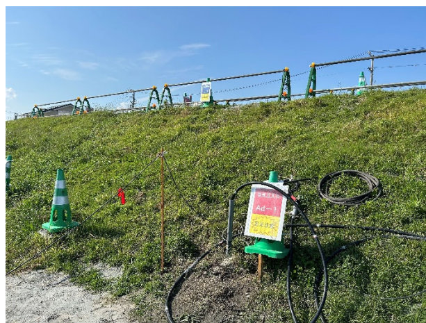
地盤内に空気を注入している様子
