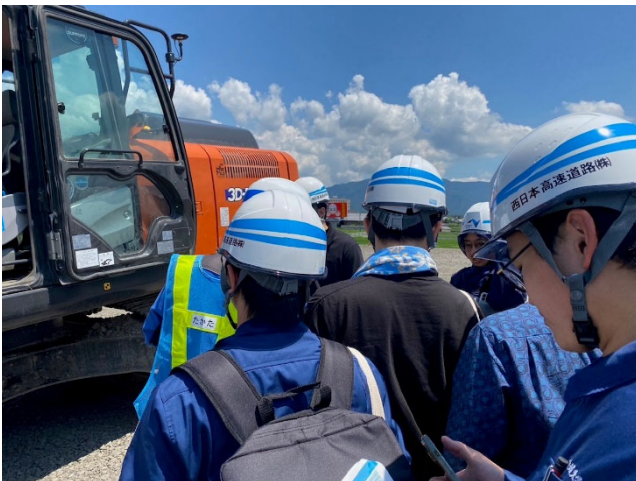
ICT 土工のバックホウを見学
