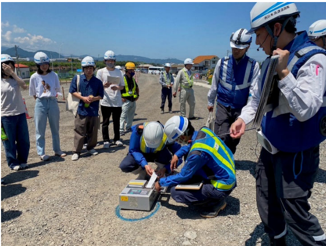
RI 計器で締固め度を測定している様子
