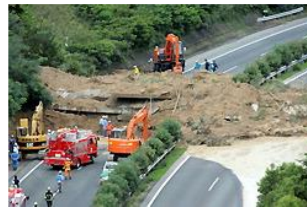
地球温暖化の影響を受けて近年多発する土砂災害(写真-1)
