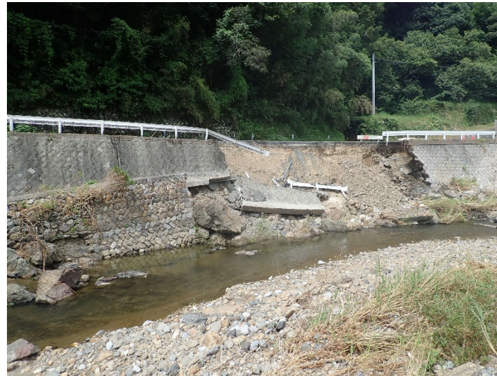
写真05 魚成川左岸側道路
