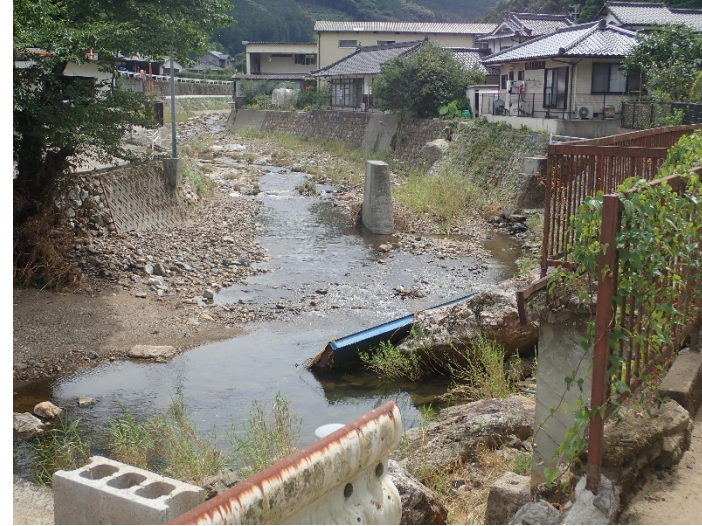
写真07 中川原橋上流側 左岸 上流方面
