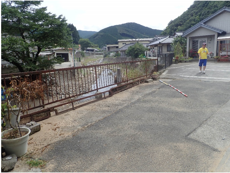
写真07 中川原橋上流側 左岸
