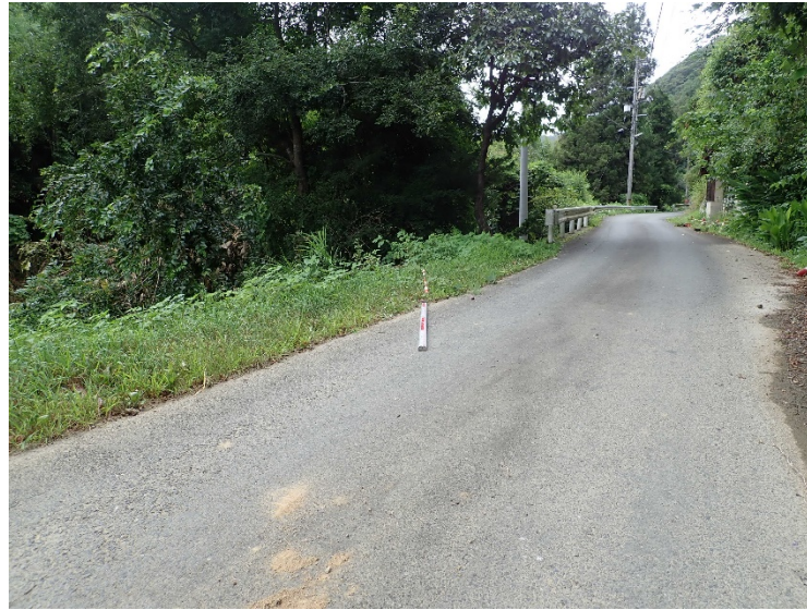
写真02 宇治橋上流左岸
