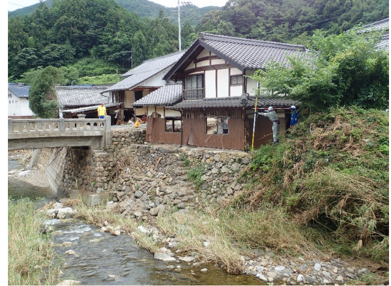
写真09 宇治橋横右岸 民家
