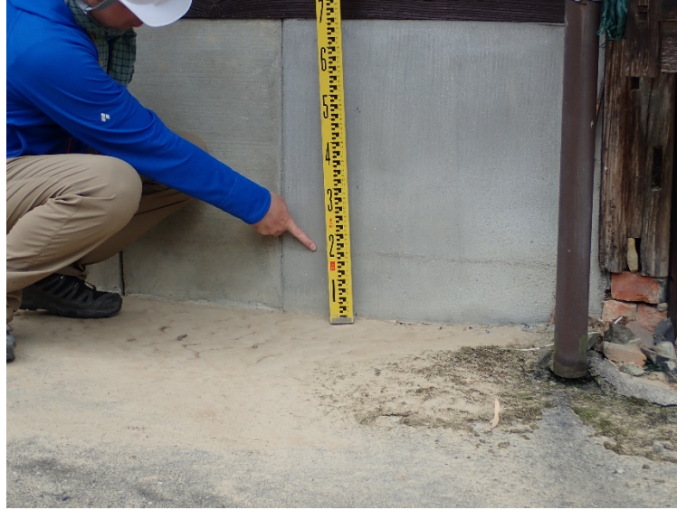
写真08 宇治橋横右岸 民家
