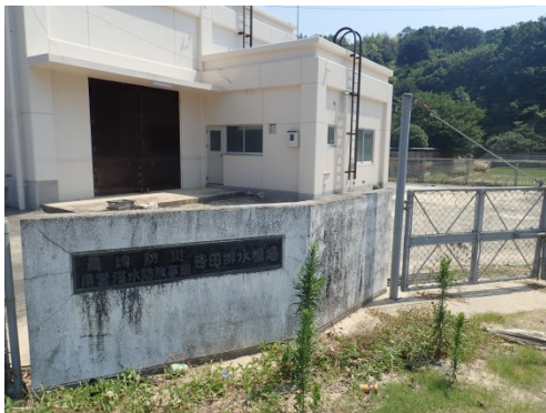
写真⑬(吉田排水機場)
