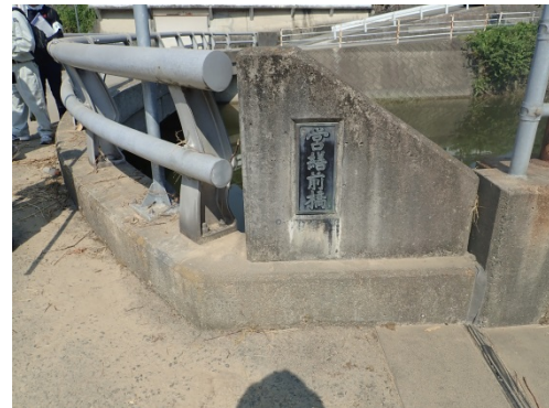
写真③(営繕前橋)
