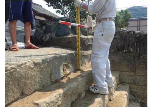
写真⑥(立間川護岸の階段)
