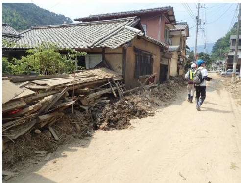
写真⑦(家屋崩壊)
