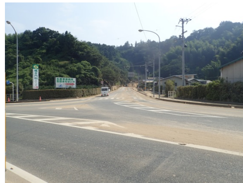
写真⑮(喜佐方トンネル東側)
