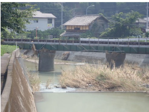
写真⑯(竹城下第1踏切南線路)
