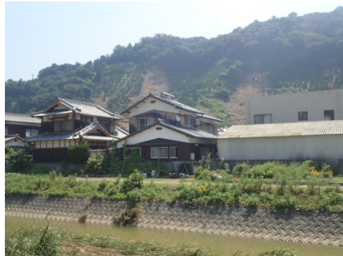
写真⑥(土砂崩れの様子)
