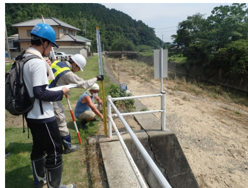
写真③(中番新橋上流左岸側)
