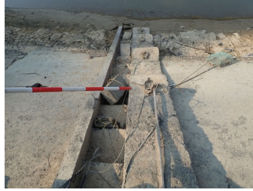
写真⑥(ため池水路調節場所)
