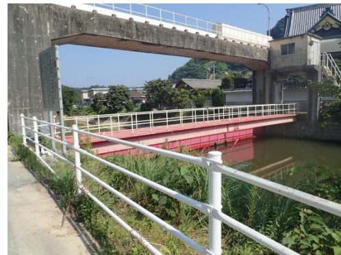
写真⑥(河内川第一水門)
