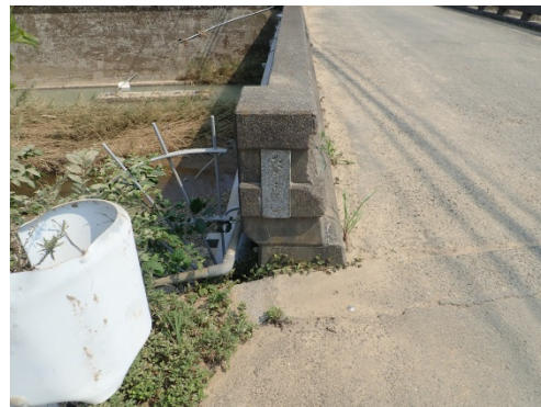
写真⑱(立間橋)
