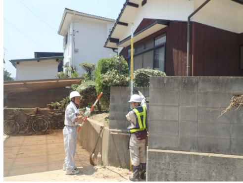
写真⑧(民家前)
