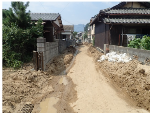
写真⑤(土砂で埋まった通路)
