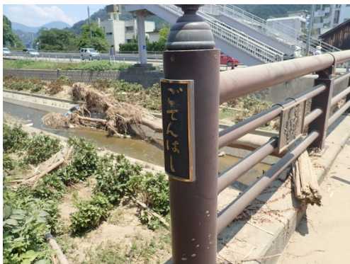
写真⑱(御殿橋)
