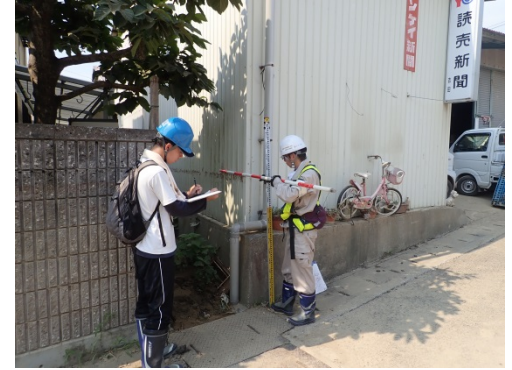
写真③(運送倉庫外壁)
