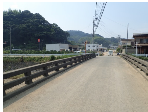
写真⑮(立間橋)
