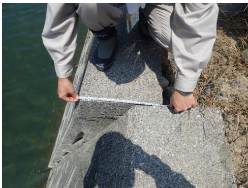
写真⑧(楠橋右岸コンクリートブロック)
