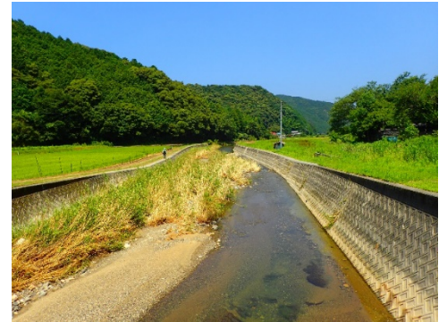
写真⑥(上屋敷橋下流)
