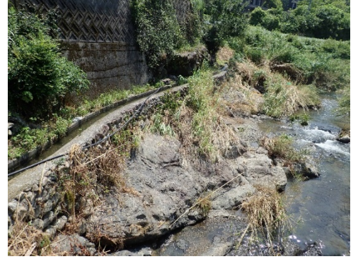
写真③(上屋敷橋上流右岸側)
