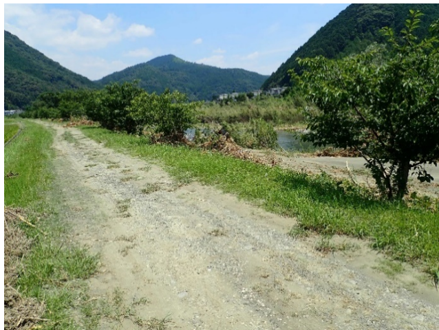
写真01 (堤内への流入)
