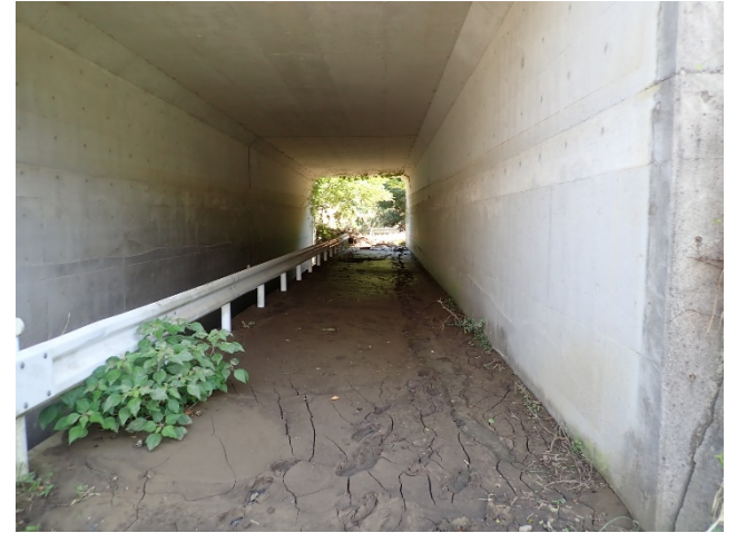
写真09 (国道318号下のボックス)
