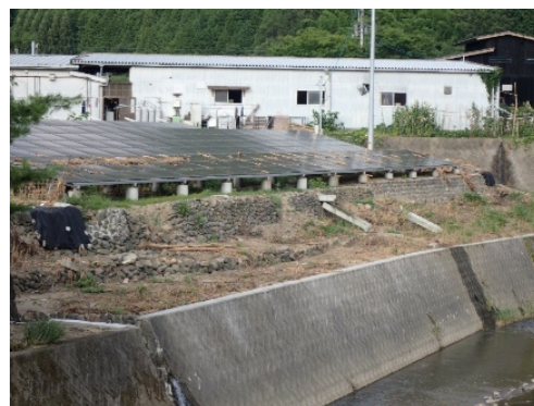
写真③(鏡川橋下流左岸側)
