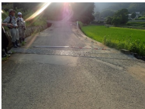
写真⑯(街灯横浸水跡)
