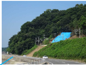
土石流被害(庄地区)
