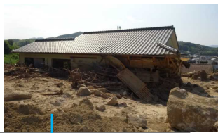
土石流被害 (伯方島・前島港)
