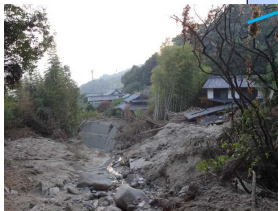
土石流被害 (大島・吉海町泊)
