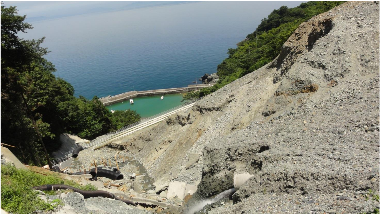
亀浦トンネル（2018年3月開通）西側の斜面
