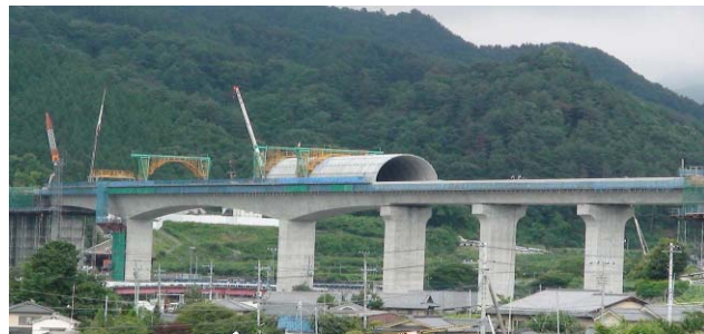
写真2. 山梨県の工事現場
